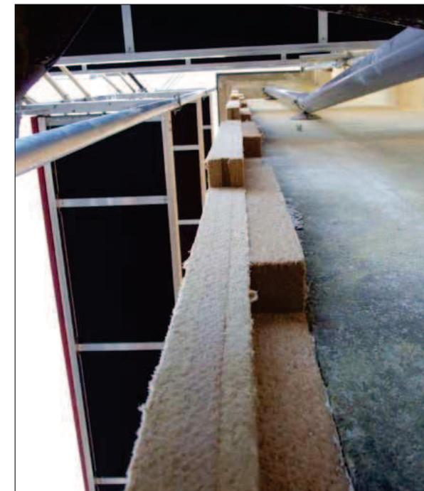
Dettaglio del montaggio dei pannelli in fibra del legno del cappotto esterno
